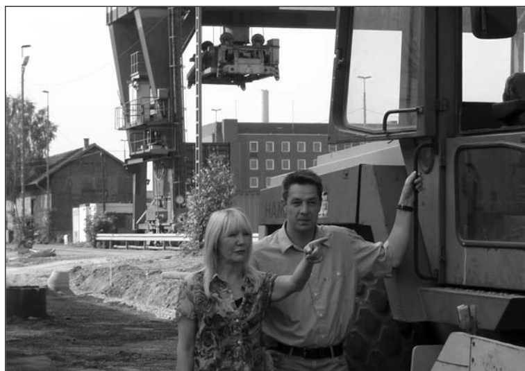
GWG-Aufsichtsrats-Mitglied Helmi Behbehani und Fraktionschef Tom Wedrins informieren sich über die Bauarbeiten.
