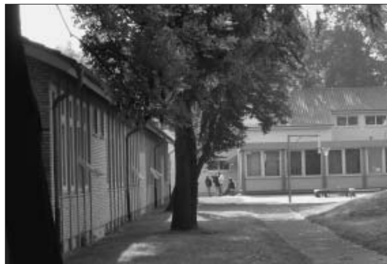
An der Heinrich-Heine-Schule in Grone wird in Kürze für den Ganztagsbetrieb gebaut. Das Land hat jedoch den Zuschuss gekürzt.
