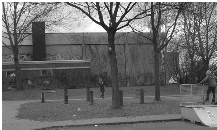
Die in die Jahre gekommene Sporthalle Geismar 1 wird an die stadteigene GöSF übertragen und nun grundlegend saniert.
